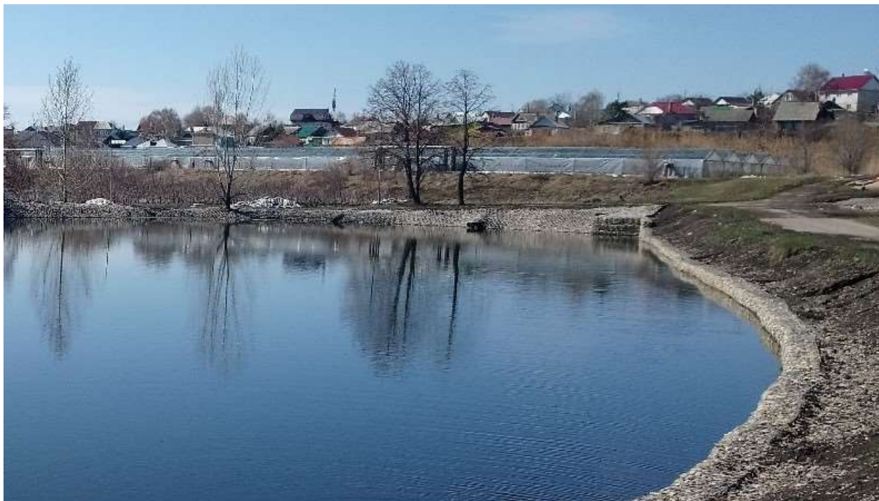
Рисунок 1 - Берегоукрепительные мероприятия на пруде «Средний»
